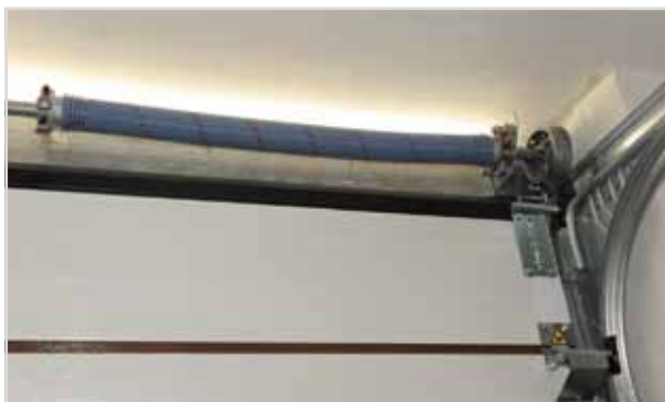
PARACADUTE CONTRO LA ROTTURA DELLE MOLLE
