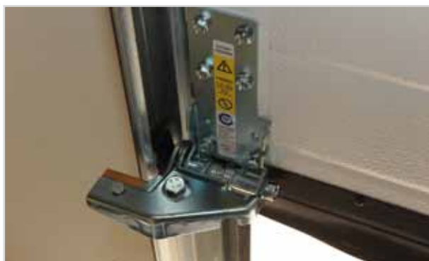
PARACADUTE CONTRO LA ROTTURA DELLE FUNI
